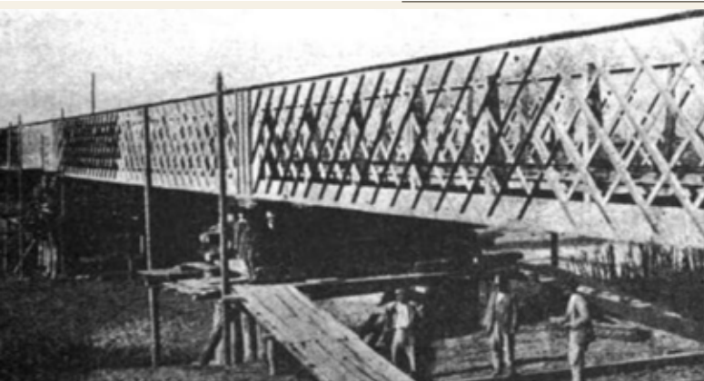
Ponte sul fiume Idice a Mezzolara prima e durante il rialzo e a lavori terminati.
